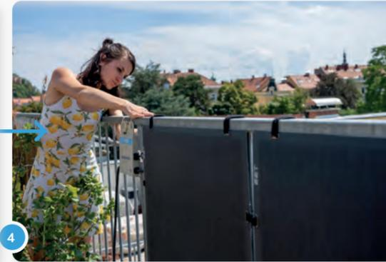
Der Wechselrichter wird dann einfach mit Kabelbindern fixiert.
