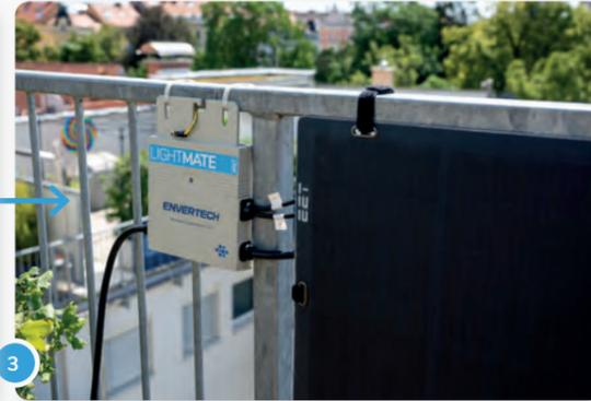
Um die Panele zu montieren, musst du sie mithilfe von Klettbändern am Geländer befestigen.
